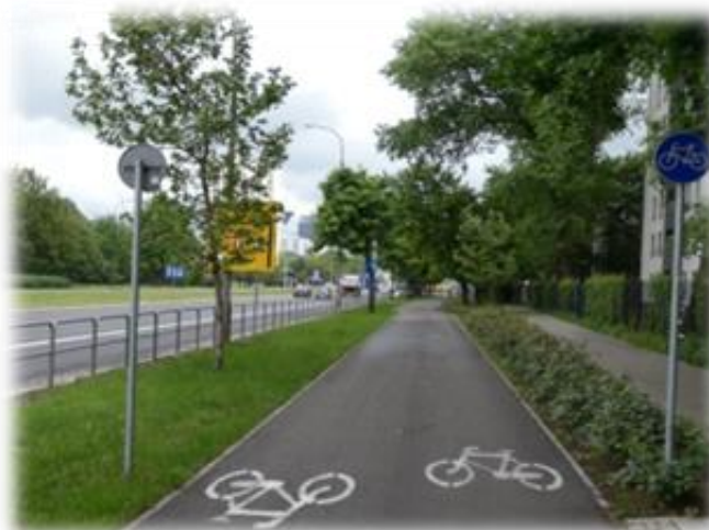
Foto nr 2. Wydzielona droga dla rowerów – dwukierunkowa z separacją zieleńcem (szerokość 2,50 m, nawierzchnia asfaltowa, oznakowanie pionowe C-13, oznakowanie poziome P-23).
