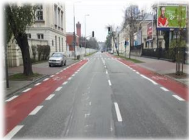
Foto. nr 5. Pasy ruchu dla rowerów (czerwona nawierzchnia) w obszarze zabudowanym.
