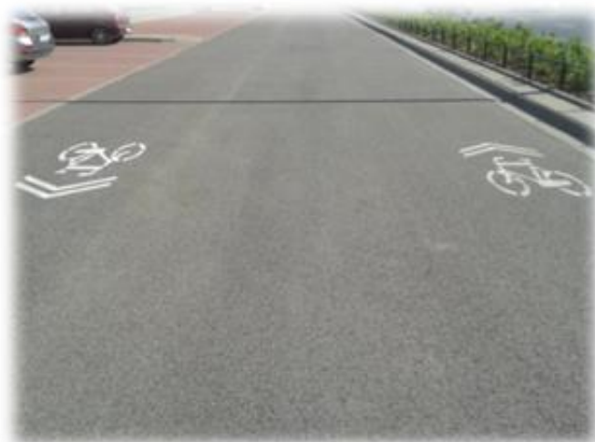
Foto nr 9. Ruch rowerów po jezdni na zasadach ogólnych z innymi użytkownikami ruchu z zastosowaniem znaku P-27.
