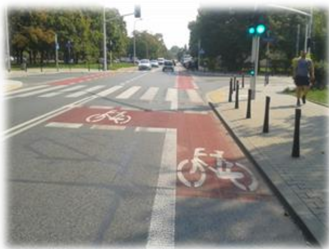
Foto. nr 10. Śluza dla rowerów na jednopasowym wlocie na skrzyżowanie z sygnalizacją świetlną. Do śluzy prowadzi pas ruchu dla rowerów umieszczony przy prawej krawędzi jezdni. W śluzie umieszczono znak poziomy P-23 „rower”.
