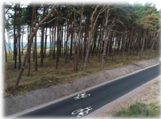
Foto. nr 14. Trasa dla rowerów - rekreacyjno-turystyczna (dwukierunkowa droga dla rowerów, naw. asfaltowa) biegnąca wzdłuż wybrzeża morza Bałtyckiego łącząca dwie miejscowości.
