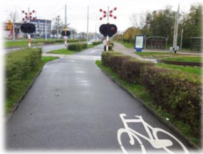
Foto. nr 12. Wlot dwukierunkowej drogi dla rowerów przez przejazd kolejowo-drogowy kategorii C.
