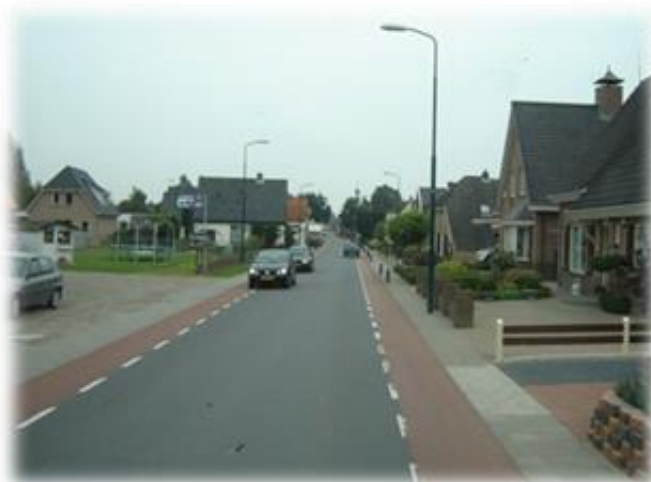
Foto. nr 6. Droga o przekroju 1/2-1 w terenie zabudowanym.
