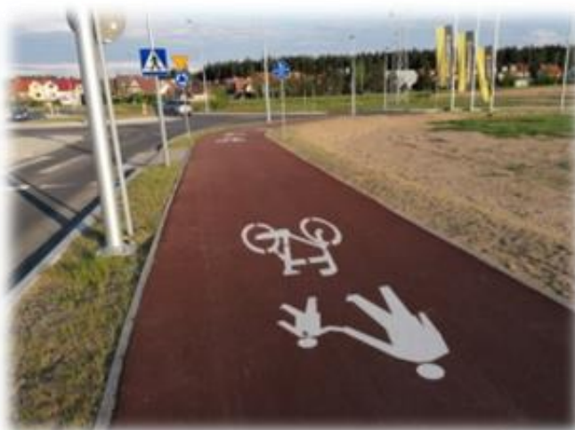
Foto nr 4. Droga dla pieszych i rowerzystów (ciąg pieszo-rowerowy). Oznakowanie poziome P-23 „rower”, P-26 „piesi”.
