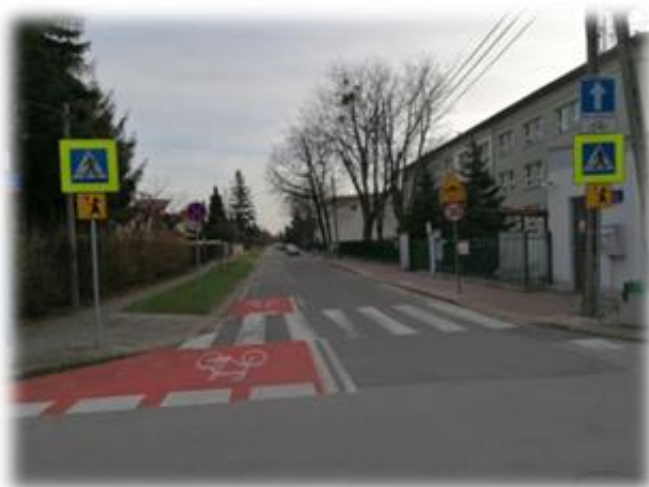
Foto nr 8. Wlot ze skrzyżowania, oznakowanie poziome barwy czerwonej w obrębie skrzyżowania, część jezdni przeznaczoną dla kontra ruchu rowerowego na ulicy jednokierunkowej.
